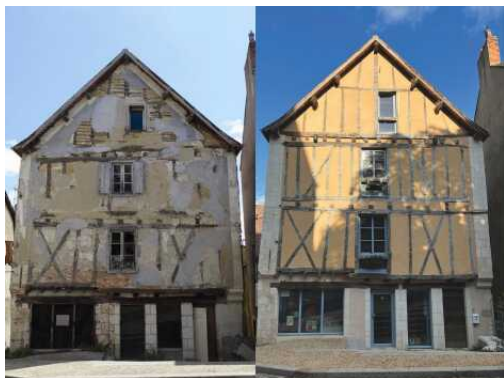
Avant/après travaux d'une maison d'Argenton (Indre) ayant obtenu le label de la Fondation du patrimoine.
